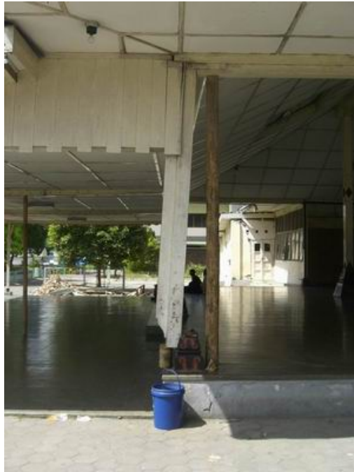
Foto 3. Tiang pendopo Taman Siswa yang lepas dari umpaknya.
